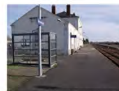
Un accès direct au quai sans cheminement par le BV
