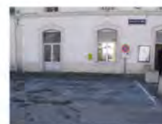
Le traitement des aménagements (ici places PMR) reste de mauvaise qualité
