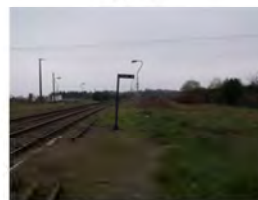
Cheminement parking/quai de mauvaise qualité
