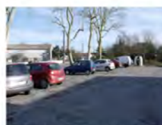
Un revêtement stationnement peu confortable pour les piétons
