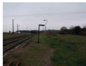
Cheminement parking/quai de mauvaise qualité
